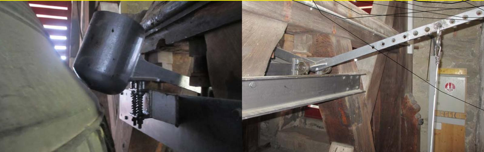
Der Fall-Schlag-Hammers in der Kathedrale St.Gallen und eine Umlenkung einer mechanischen Steuerung.
